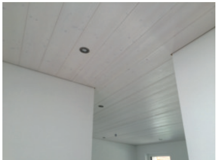
Bild: BIG-SIZE Trend gechliffen | Deckengestaltung im EFH-Neubau
