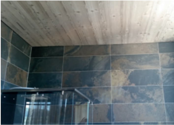
Bild: Deckengestaltung im Bad (feuchtraumgeeignet)
