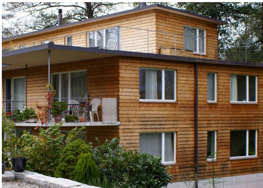
Fassade aus thermisch vergütetem Holz, zwei Jahre nach der Erstellung. Die Farbe ist nicht UV-stabil, jedoch beständiger, als bei unbehandeltem Holz.
