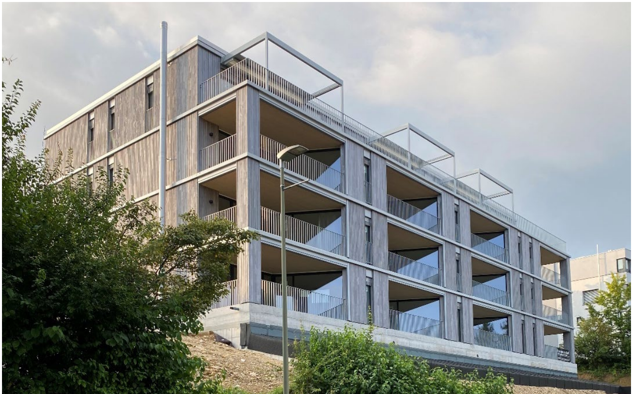
Bild 1: Das Mehrfamilienhaus Fasanenhof in Frenkendorf, bei welchem Brettspertholzelemente von Balteschwiler mit der Technologie von TS3 verklebt wurden (Architektur: Scherer Architekten AG, Liestal).
